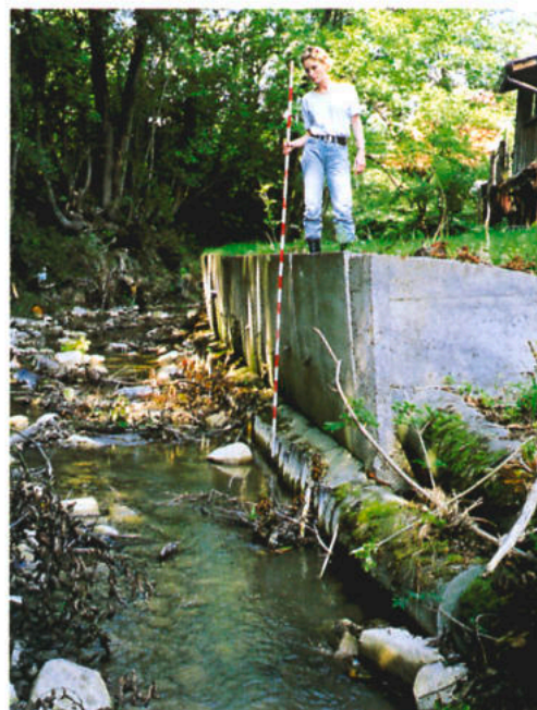
Abb. C-8: Problematische Uferverbauung in der Absicht, Land zu gewinnen
