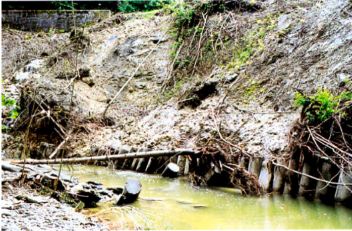
Abb. C-9: Unzweckmässige Uferverbauung, am 14.6.1999 beschädigt
