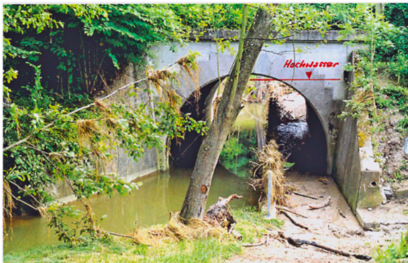
Abb. C-14: Das extreme Hochwasser hat den gesamten Bahnbrückenquerschnitt beansprucht
